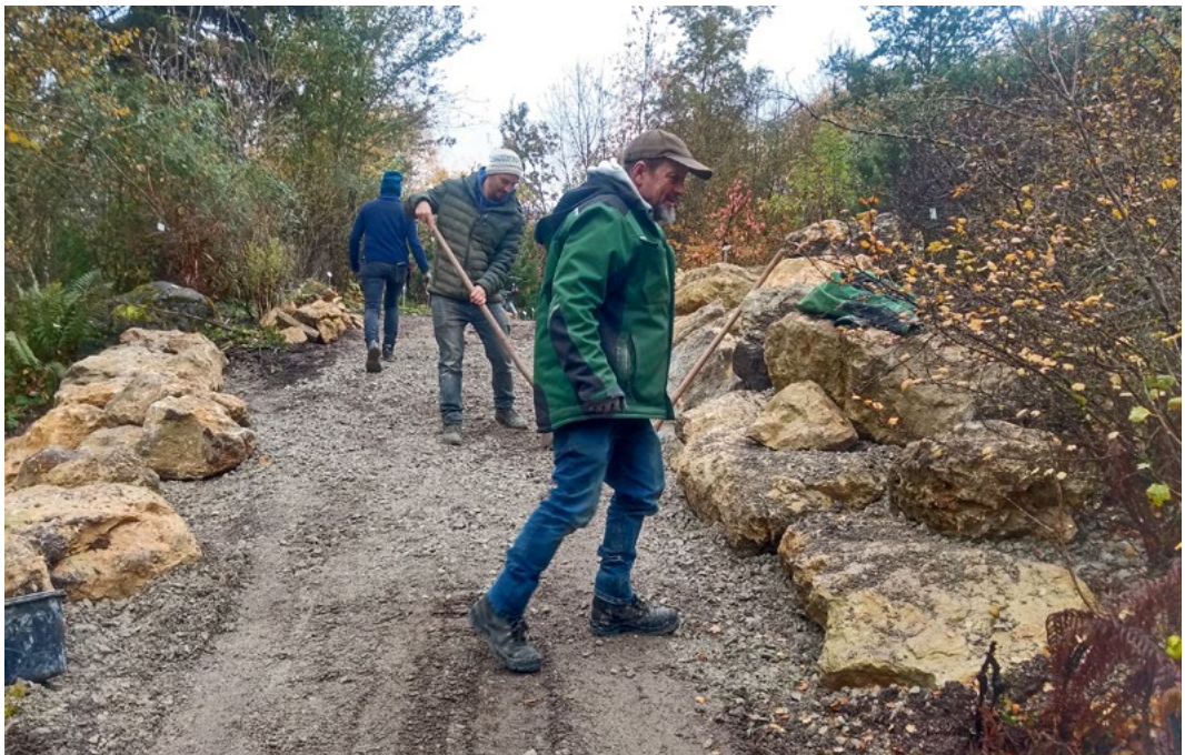
Abb. 26: Neubau eines Weges in den Kalkalpen. (Foto: Heike Schwarzer)
