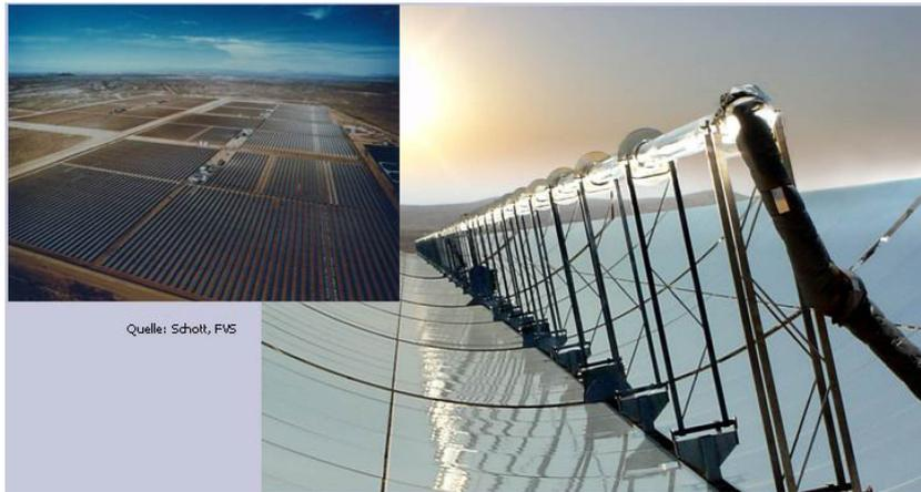
Abbildung 7.13: Solarthermische Kraftwerke.
