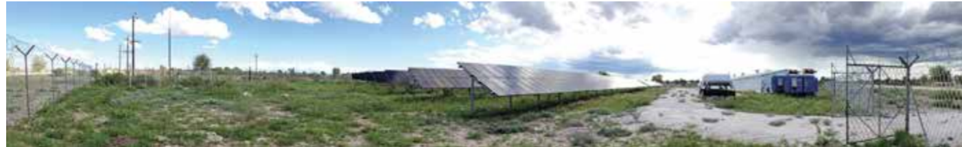
Photovoltaik-Anlage in Gam, einem Ort in der Region Otjozondjupa im Nordosten von Namibia. Foto: Fabian Junker, TH Ingolstadt
