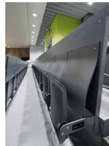
Ein Detail der H15-Sanierung – sämtliche Oberflächen sind hier neu: Neu gestaltete Bestuhlung, neue Böden, neue akustisch wirksame Deckenverkleidungen mit neuer energiesparender und hocheffizienter Beleuchtung, neue Akustik-Wandverkleidungen...und alles in ein neues Farbkonzept gehüllt. Fotos: Peter Kolb
