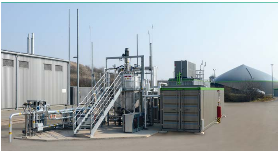
■ Abb. 3: Power-to-Gas-Anlage mit biologischer Methanisierung in Allendorf/Hessen. Im Elektrolyseur wird überschüssiger Strom in Wasserstoff umgewandelt (Foto: Viessmann Werke).
