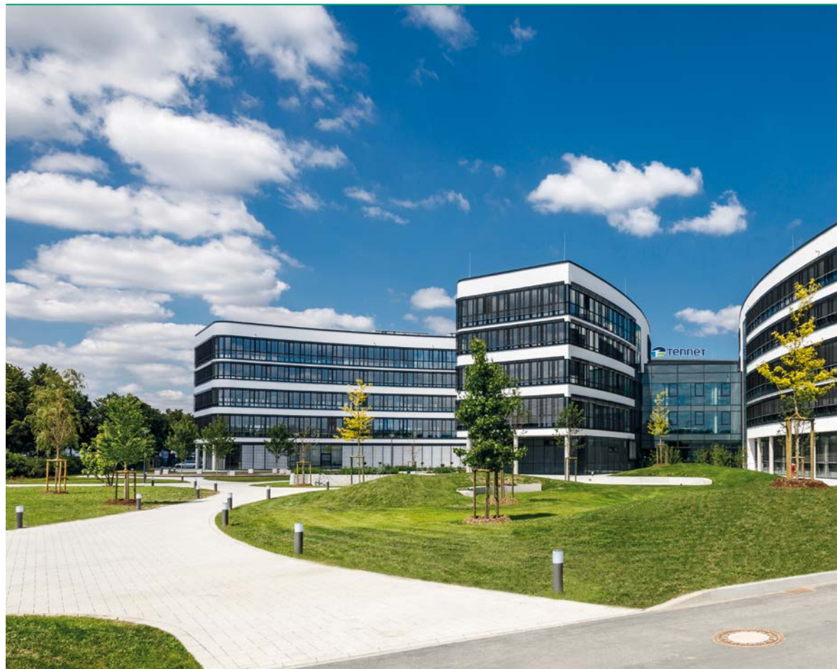
■ Abb. 1: Das Hauptgebäude der TenneT TSO GmbH in Bayreuth (Foto: TenneT TSO GmbH).
