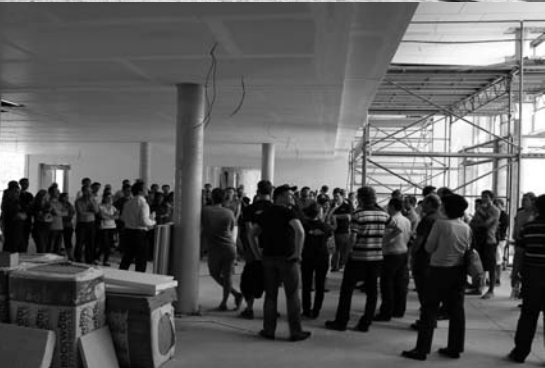
Großer Andrang bei den Baustellenführungen
