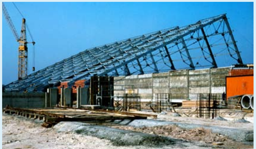
Tropenwaldhaus im Aufbau 1986
