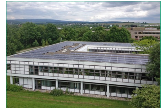
Blick auf die Photovoltaik-Anlage auf dem Dach des Gebäudes GEO II rund um dessen Atrium.
