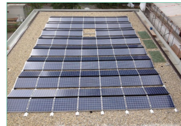
Blick auf die Photovoltaik-Anlage auf dem Dach von GEO I
