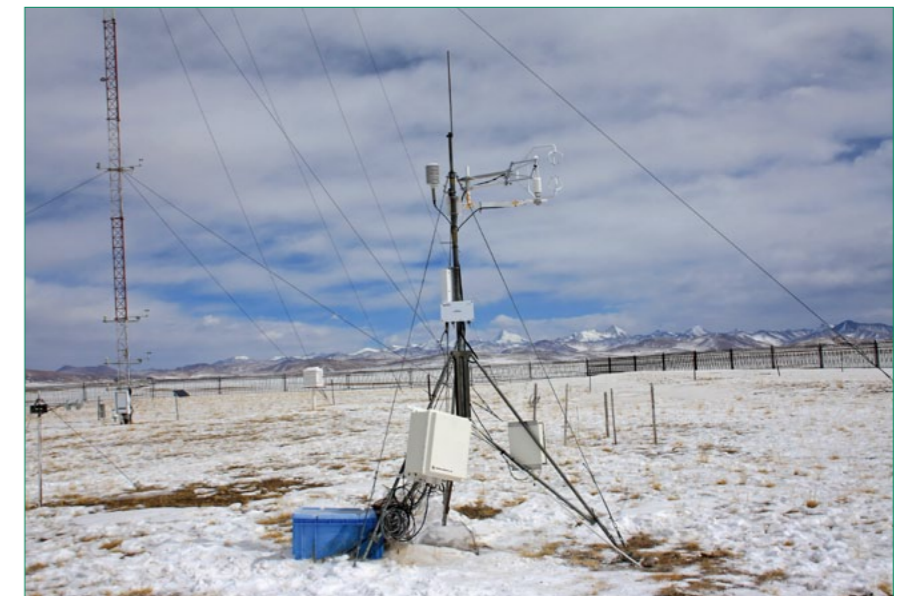
Meteorologische Messeinrichtungen der Station Nam Co (4.730 m) des ITP
