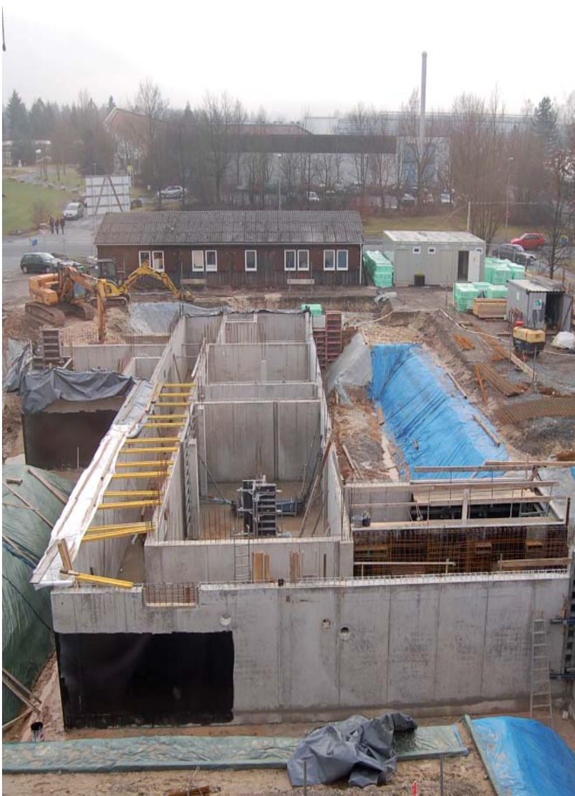
Ein Anfang ist gemacht: Im Herbst 2012 wird das Forschungsgebäude Polymer Nanostructures den Wissenschaftlern zur Verfügung stehen.
