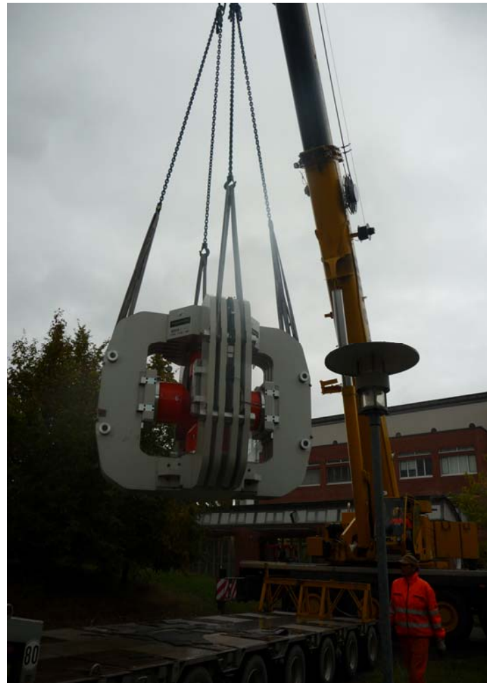
Hing sicher am Haken eines Autokrans: die neue Großpresse des Bayerischen Geoinstituts.
