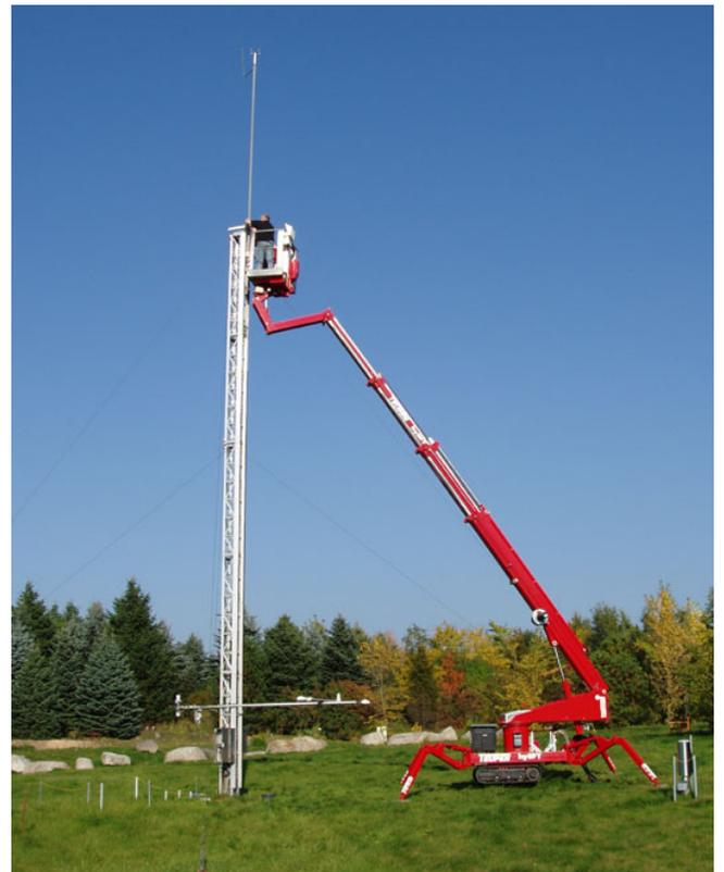
Austausch des Ultraschall-Windmessgerätes und Montage der Richtfunkantenne (WLAN) an der Mastspitze
