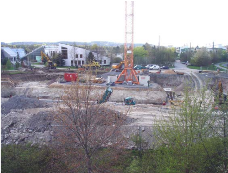
Noch geht es in die Erde hinein. Doch spätestens in zwei Jahren wird hier auf drei Ebenen das Gebäude der Angewandten Informatik entstanden sein. Auf dem Bild hinter der Baustelle links das Gebäudekomplex des Ökologisch-Botanischen Gartens, rechts im Hintergrund der der Fakultät für Angewandte Naturwissenschaften.
