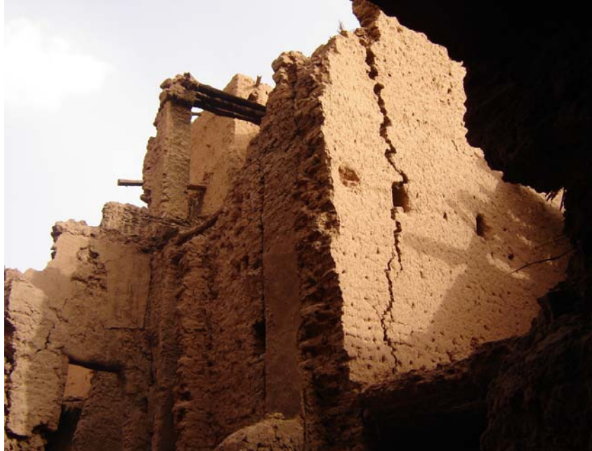
Photo 31 : Ksar d'Oulad Driss à un stade avancé de délabrement, et le risque d'effondrement est signalé en français aux touristes
