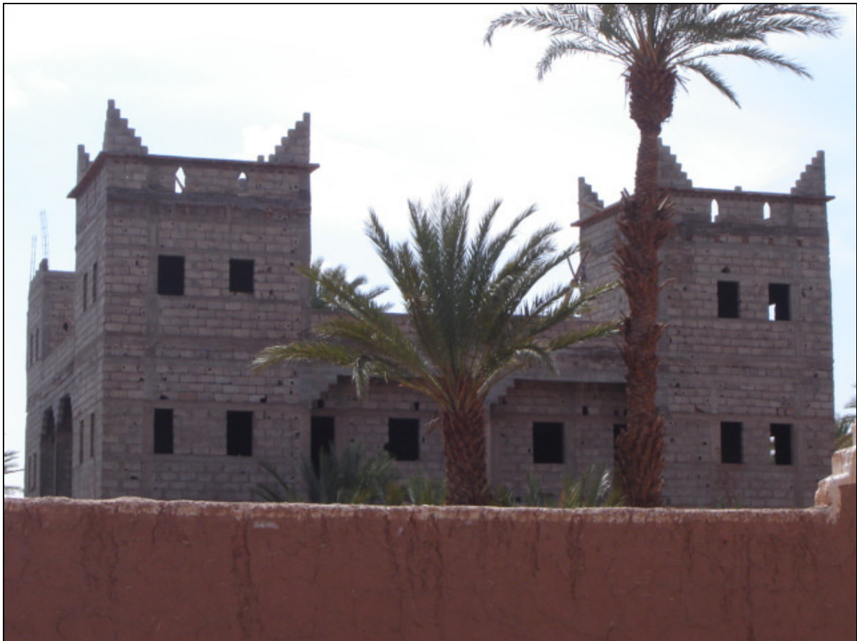
Photo 30 : Kasbah construite en béton armé, extension du camping Carrefour des caravanes
