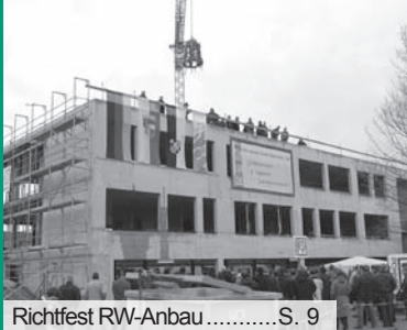
Richtfest RW-Anbau .....S. 9
